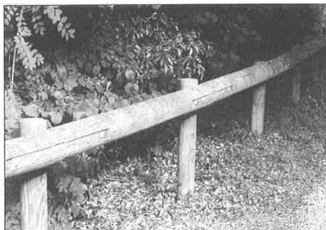
La barrière en bois s'appuie sur le massif végétal. D90. PNR de Brotonne.
