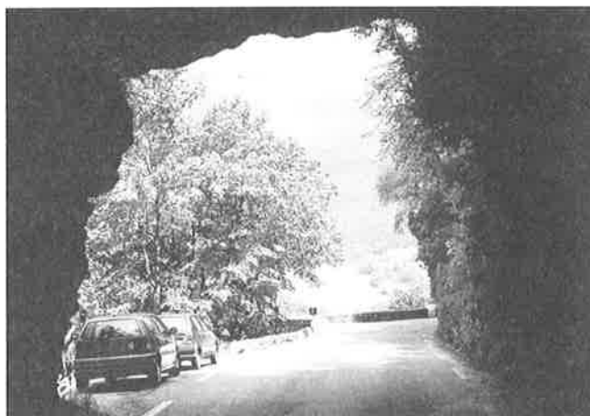
La végétation prolonge l'effet de la paroi et permet de découvrir la vue là où elle est la plus intéressante. D518 ; Les petits Goulets. PNR du Vercors.
