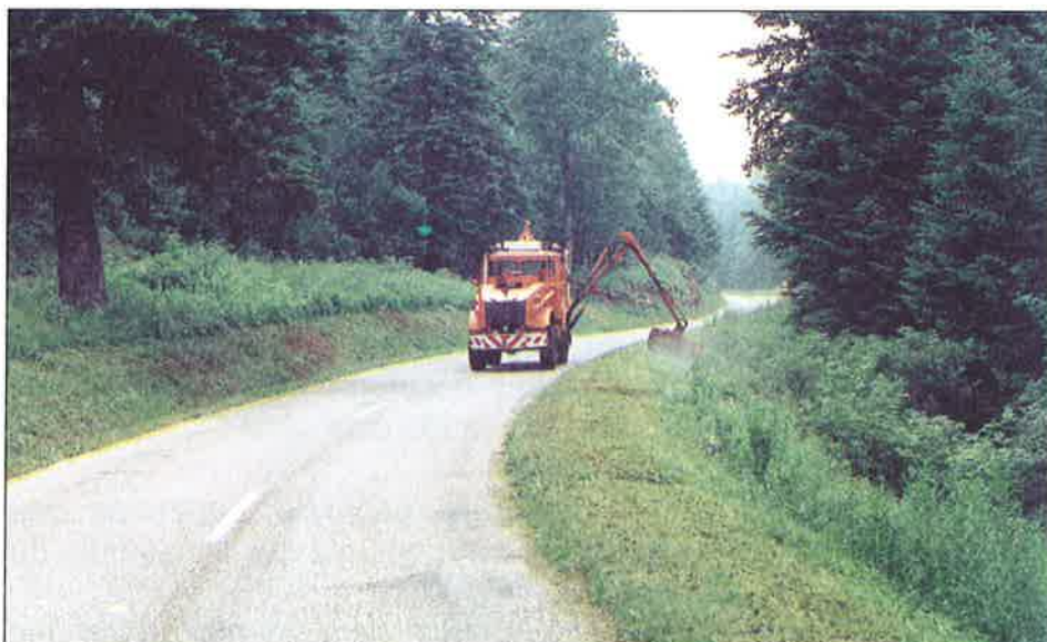
Fauchage régulier d'une bande herbacée entre la chaussée et la végétation spontanée. PNR du Vercors
