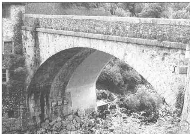
Le pont du Rouillard a été élargi en reprenant les mêmes formes et les mêmes matériaux que ceux de l'ouvrage existant. D 531. PNR du Vercors.
